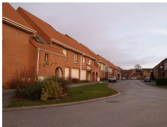
Constructions récentes plus denses
