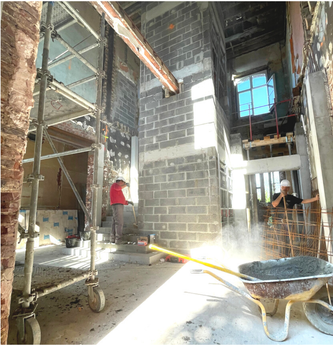
À l'intérieur, une cage d'ascenseur et escalier sont en construction. Sur les façades, sablage et rejointoiment ont été réalisés, tout comme la pose de fenêtres. À l'intérieur, des poutres métalliques ou en bois ont été installées.
