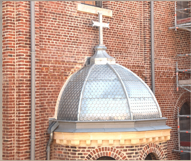
Travail d'orfèvre de zinc au niveau des demi-coupoles.
