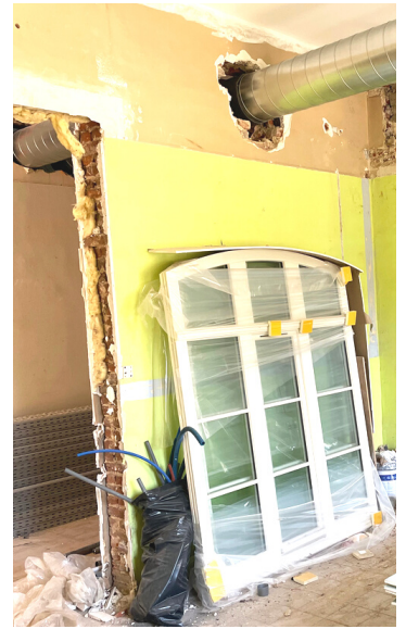
À l'intérieur, une cage d'ascenseur et escalier sont en construction. Sur les façades, sablage et rejointoiment ont été réalisés, tout comme la pose de fenêtres. À l'intérieur, des poutres métalliques ou en bois ont été installées.
