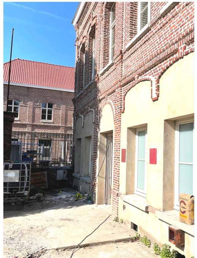
À l'intérieur, une cage d'ascenseur et escalier sont en construction. Sur les façades, sablage et rejointoiment ont été réalisés, tout comme la pose de fenêtres. À l'intérieur, des poutres métalliques ou en bois ont été installées.
