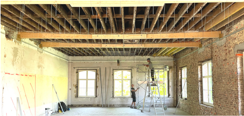
À l'intérieur, une cage d'ascenseur et escalier sont en construction. Sur les façades, sablage et rejointoiment ont été réalisés, tout comme la pose de fenêtres. À l'intérieur, des poutres métalliques ou en bois ont été installées.
