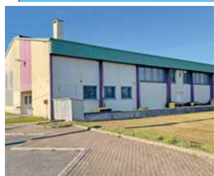
Travaux salles Maistre et Viard 1,7 M€ (1 M€ de subventions)
