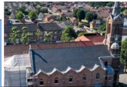
Rénovation église Sainte-Barbe 1,7 M€ (1 M€ de subventions)
