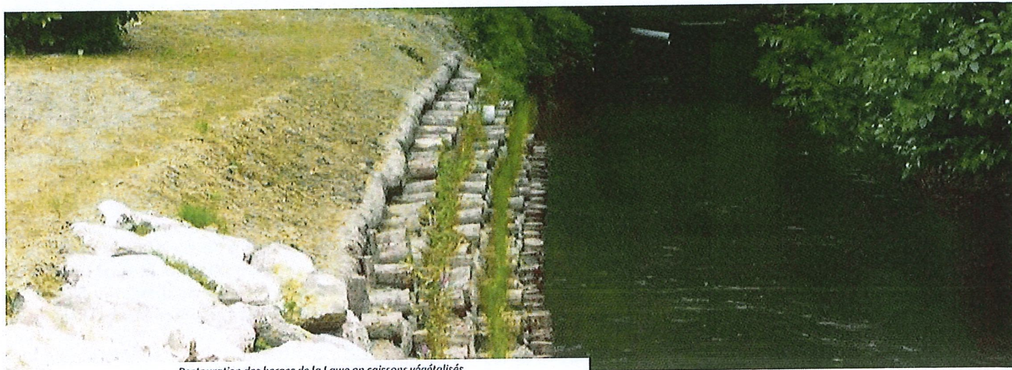
Restauration des berges de la Lawe en caissons végétalisés
