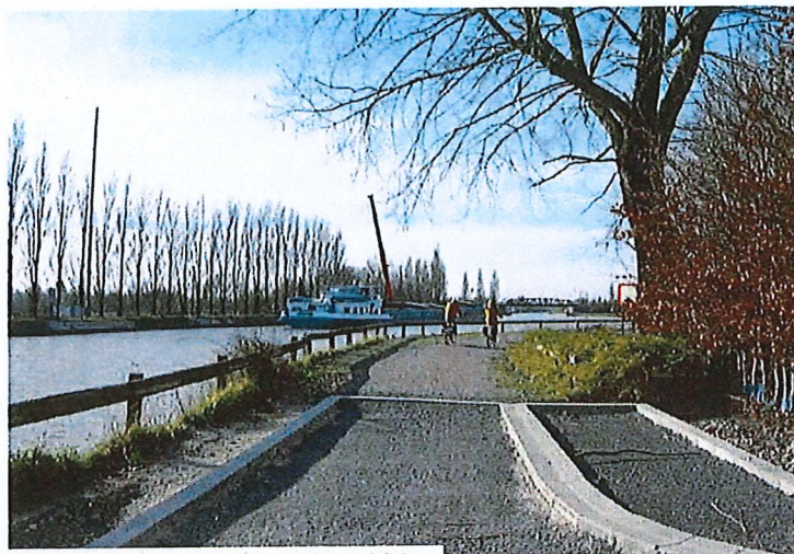
Travaux d'aménagement véloroute du canal d'Aire
