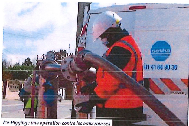
Ice-Pigging : une opération contre les eaux rouges
