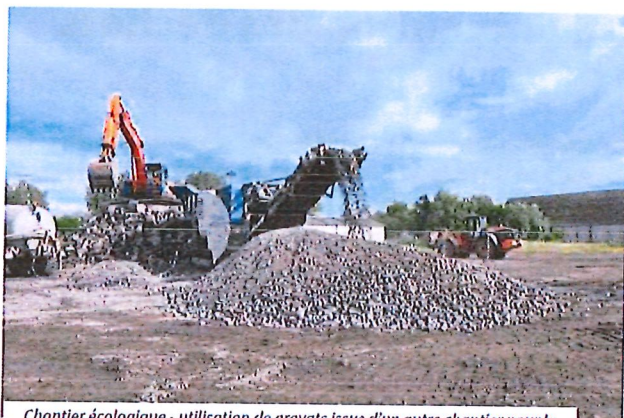
Chantier écologique - utilisation de gravats issus d'un autre chantier pour la construction d'un nouveau bâtiment commercial.
