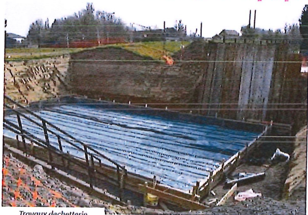
Travaux de déchetterie
