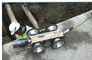
Inspection caméra après nettoyage
