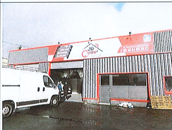
Façade bardage en façade
